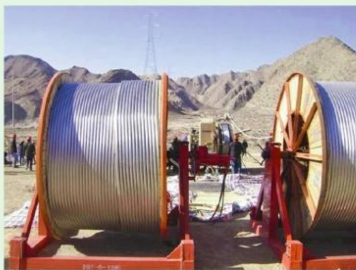
图1-1 架设高性能铝合金导线现场
