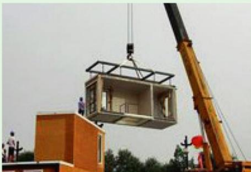
图3-13 3D打印别墅建设中
