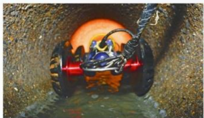
甲 机器人在下水道里探测水下管网
