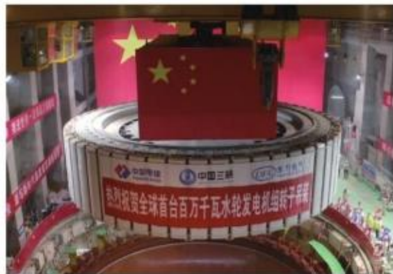
图3.1-8 白鹤滩水电站一台正在吊装的百万千瓦机组发电机转子
