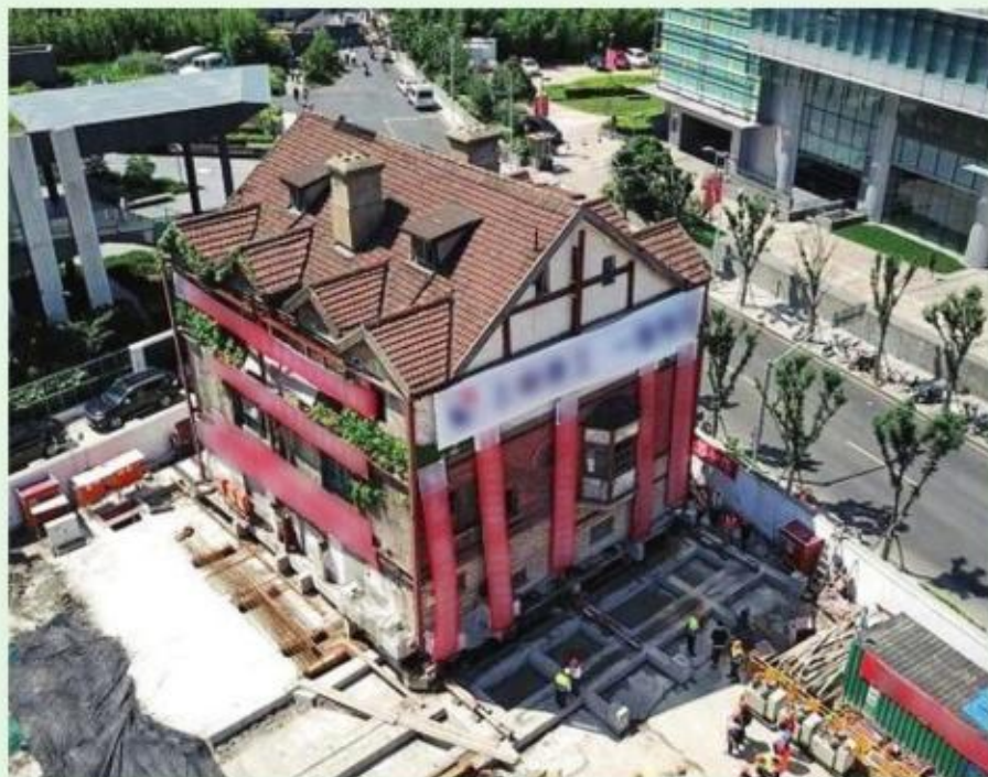
图1-5 建筑平移施工现场
