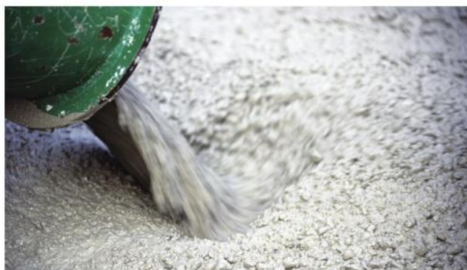
图1-23 浇筑水泥混凝土
