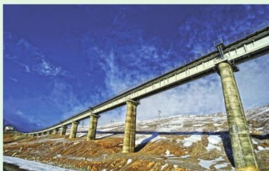
图 1-6 青藏线铁路桥
