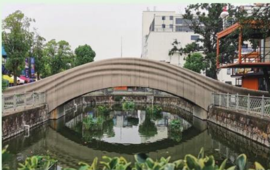
图1-4 三维打印桥梁
