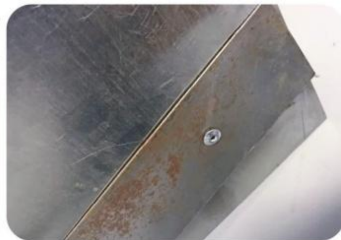
5. 将钉子插入两片金属板的钻孔中，压紧 铆钉枪。
