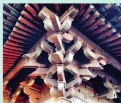
◇ 紫禁城建筑屋顶
