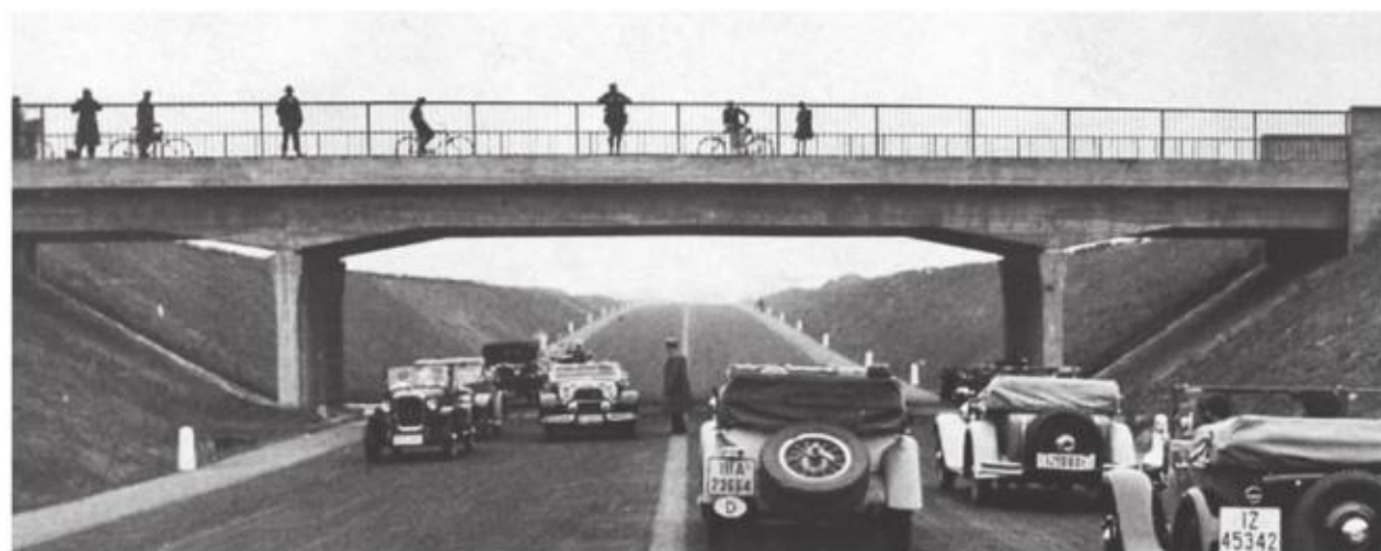
▲ 通行之初的科隆—波恩高速公路
