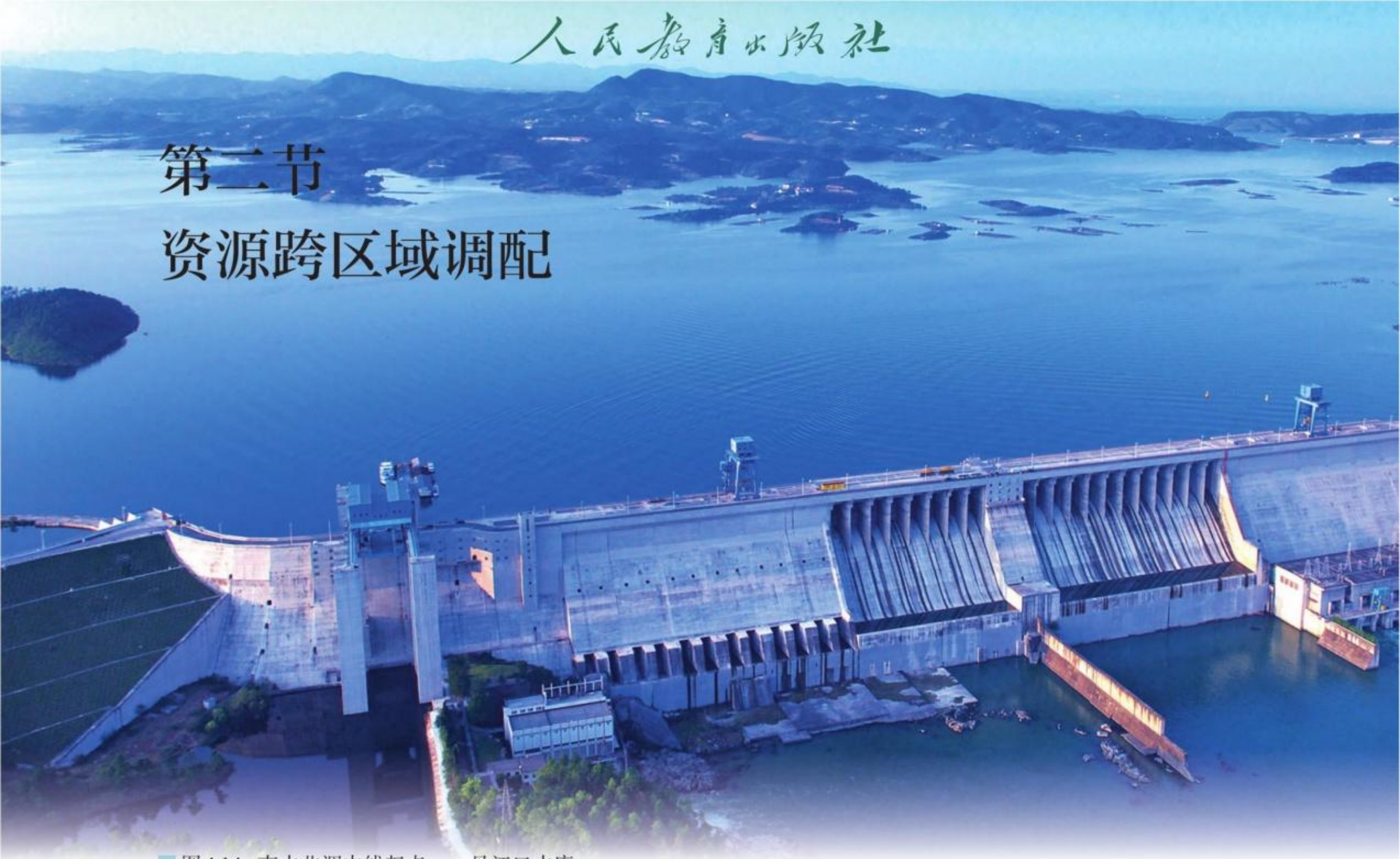
图4.14 南水北调中线起点——丹江口水库
