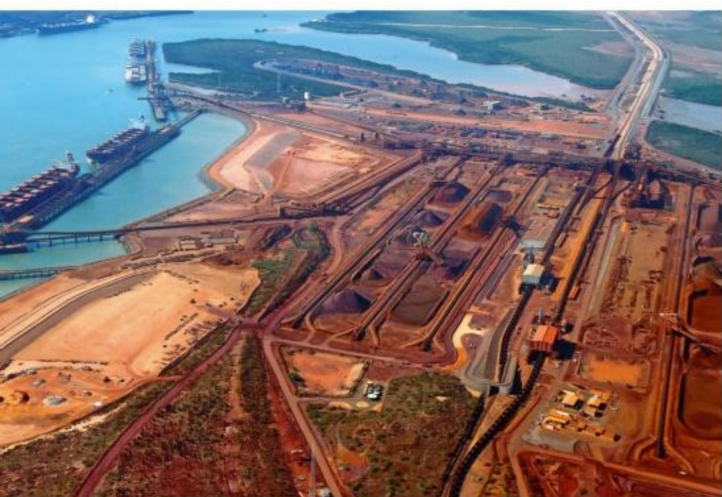
图2.1 澳大利亚运输铁矿石的港口
