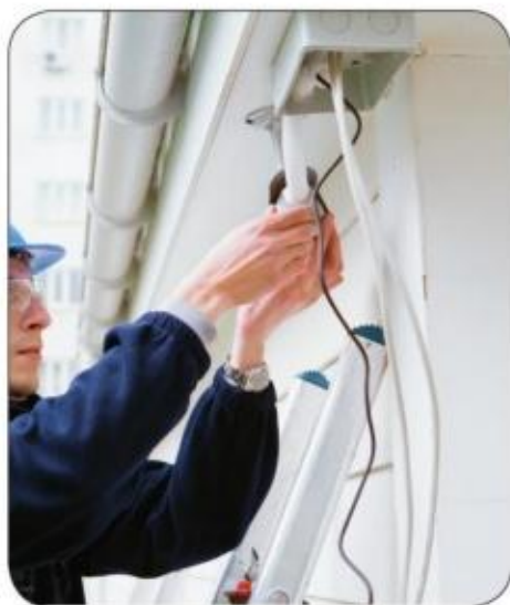
图2.2.5 现场安装设备
