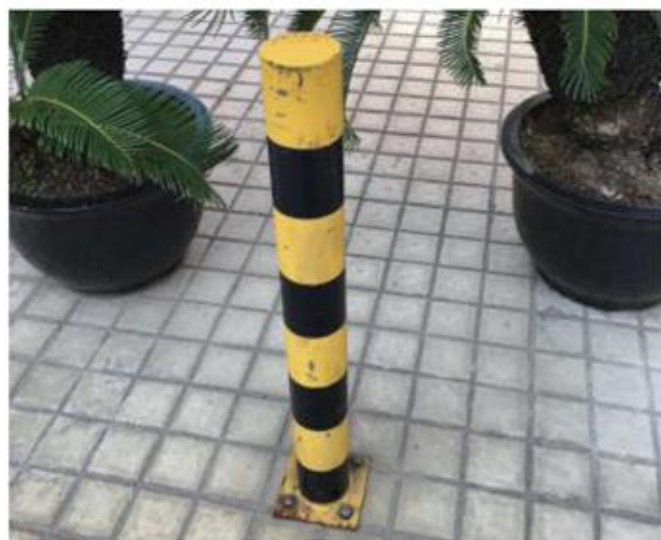
图1-33 安全桩与地面的螺栓连接
