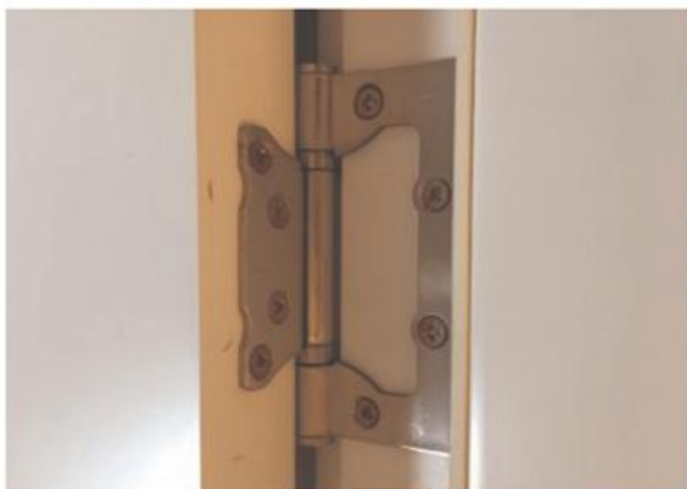
图1-32 门与门框的连接
