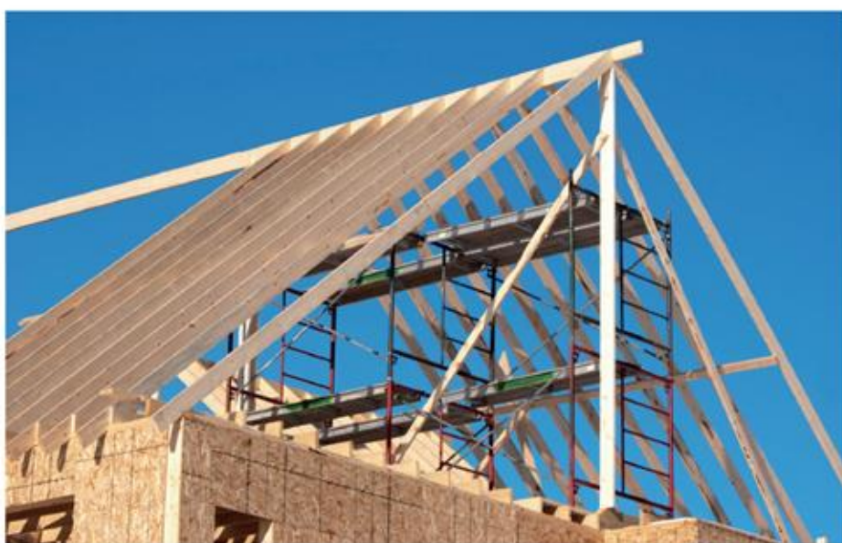
图 1-27 屋顶三角形桁架
