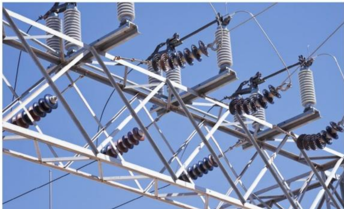
图 5-20 高压输电线路使用了陶瓷绝缘材料
