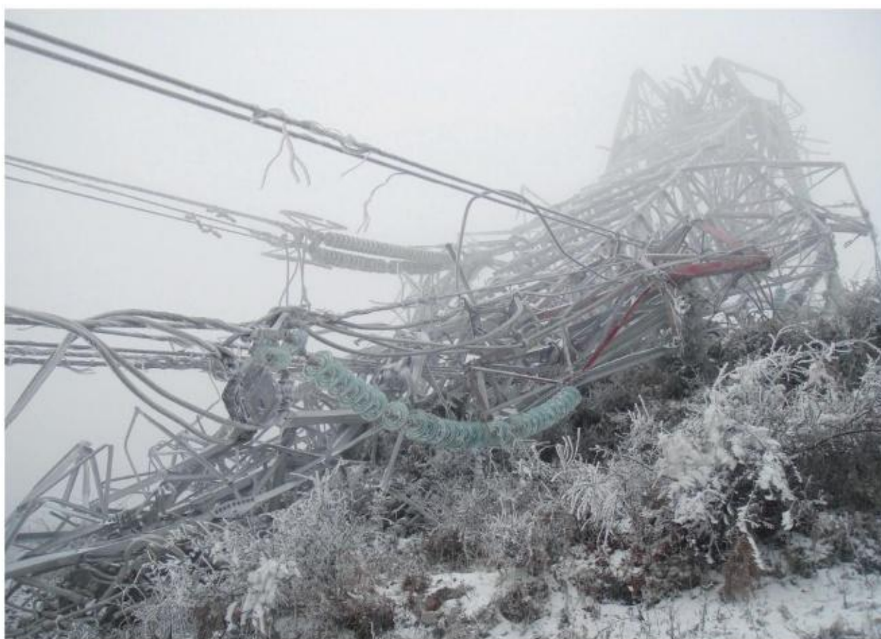
图6.8 寒潮破坏输电线路
