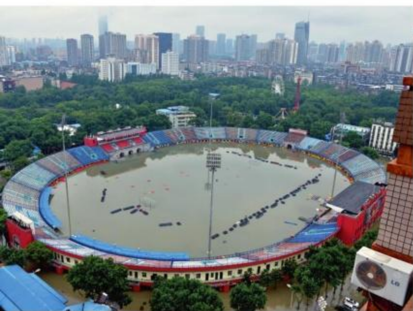
图6.1 2016年7月6日武汉新华路体育场内的积水
