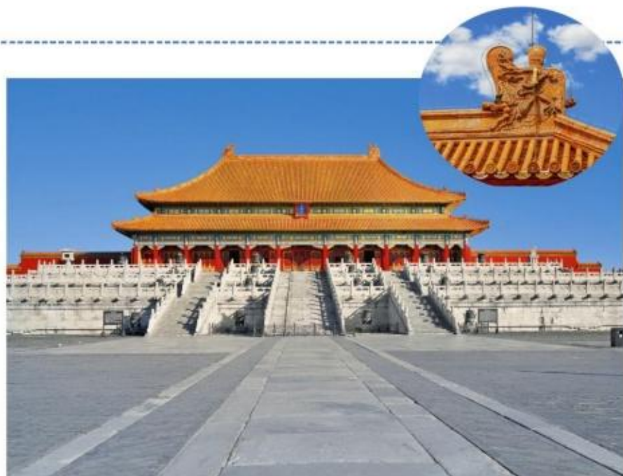
图19.1-7 古建筑上加装的防雷装置
