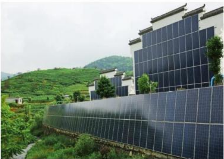
图22.3-1 农村住宅加装的太阳能电池板
