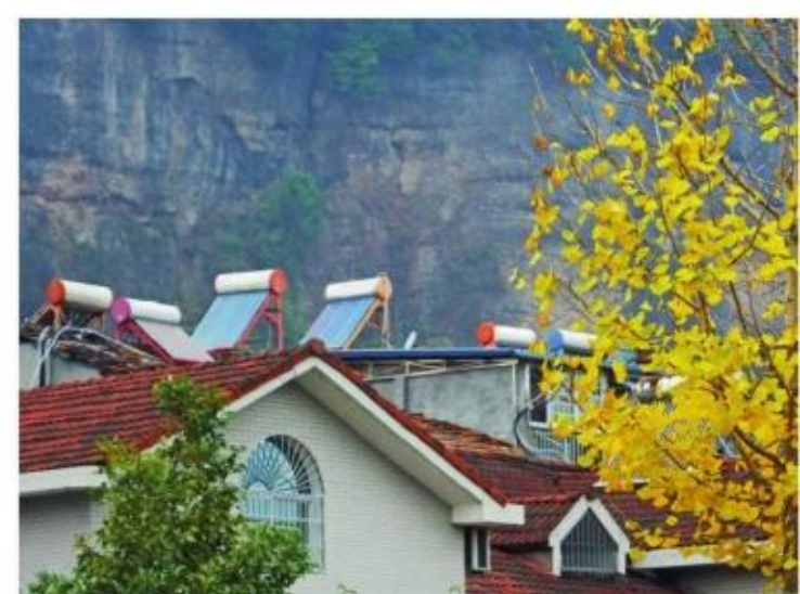
图22.2-8 屋顶的太阳能集热器
