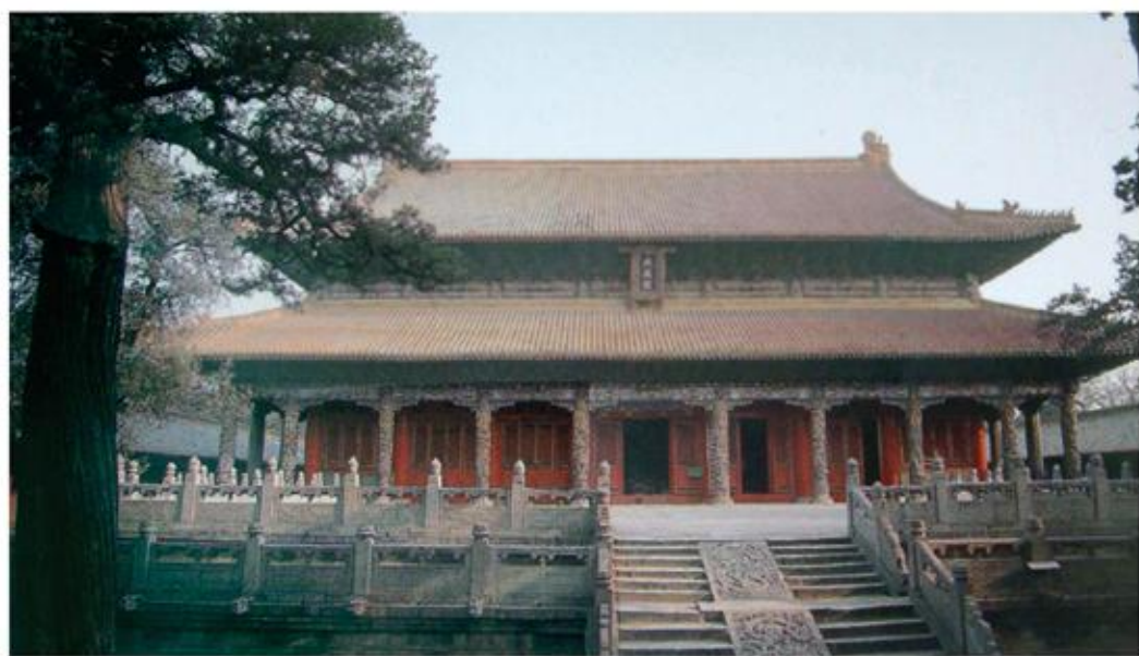
▲ 山东曲阜孔庙大成殿（建筑）
