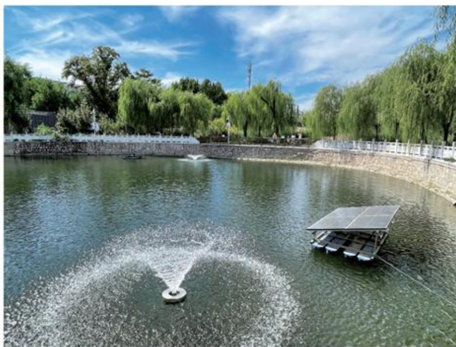
图 9-14 把水喷向空中可以增加水中氧气的溶解量
