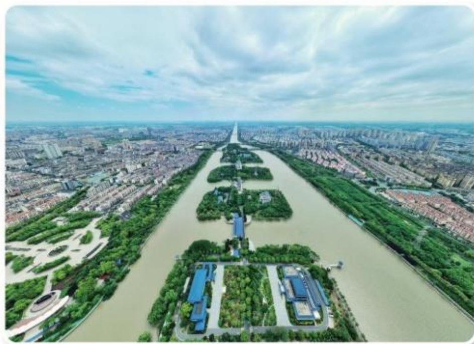
南水北调东线工程源头——江苏省扬州市江都水利枢纽
