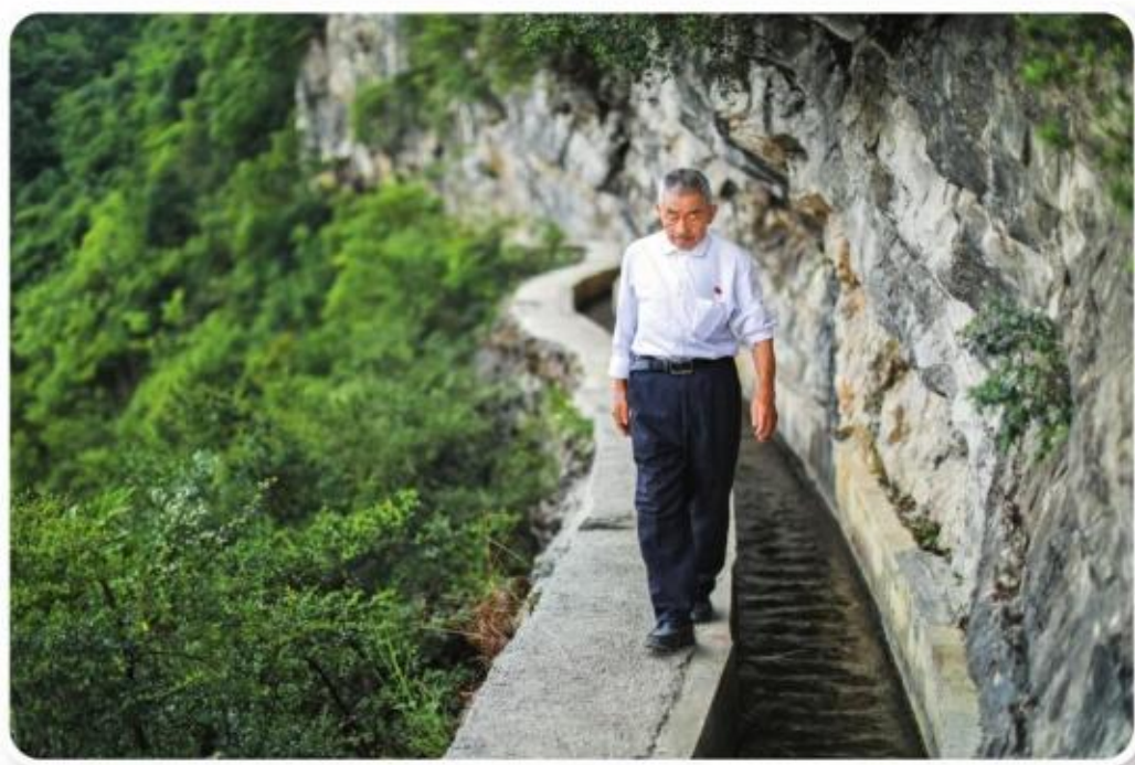
黄大发沿着修建在绝壁上的“大发渠”巡查
