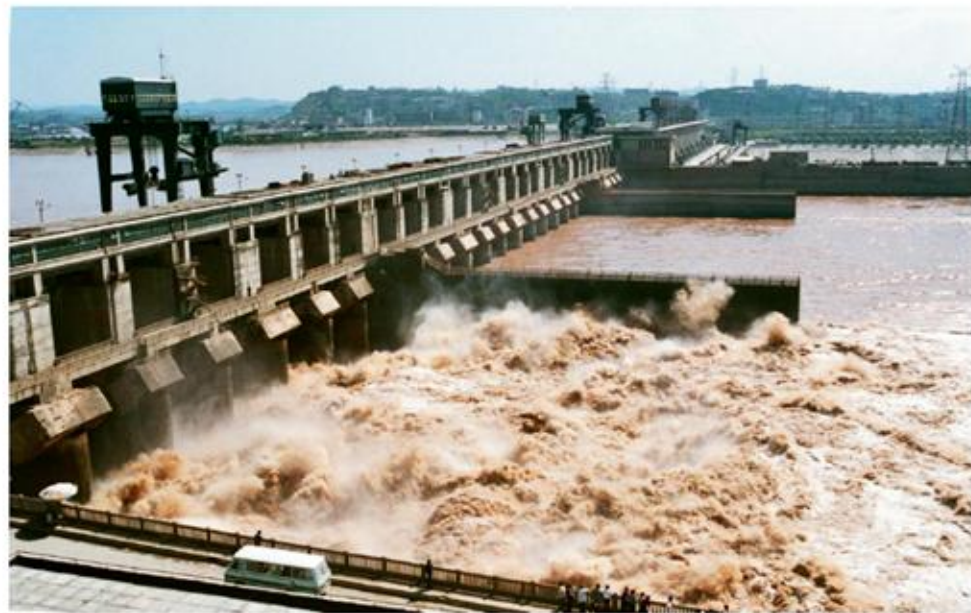
1970年动工兴建的葛洲坝水利枢纽工程
